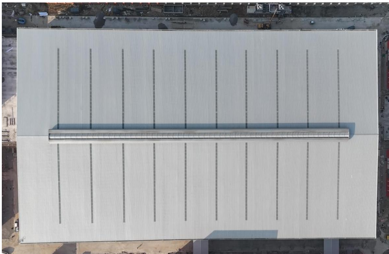
屋面板铺设平整顺直，天沟排水通畅，节点密封完善
