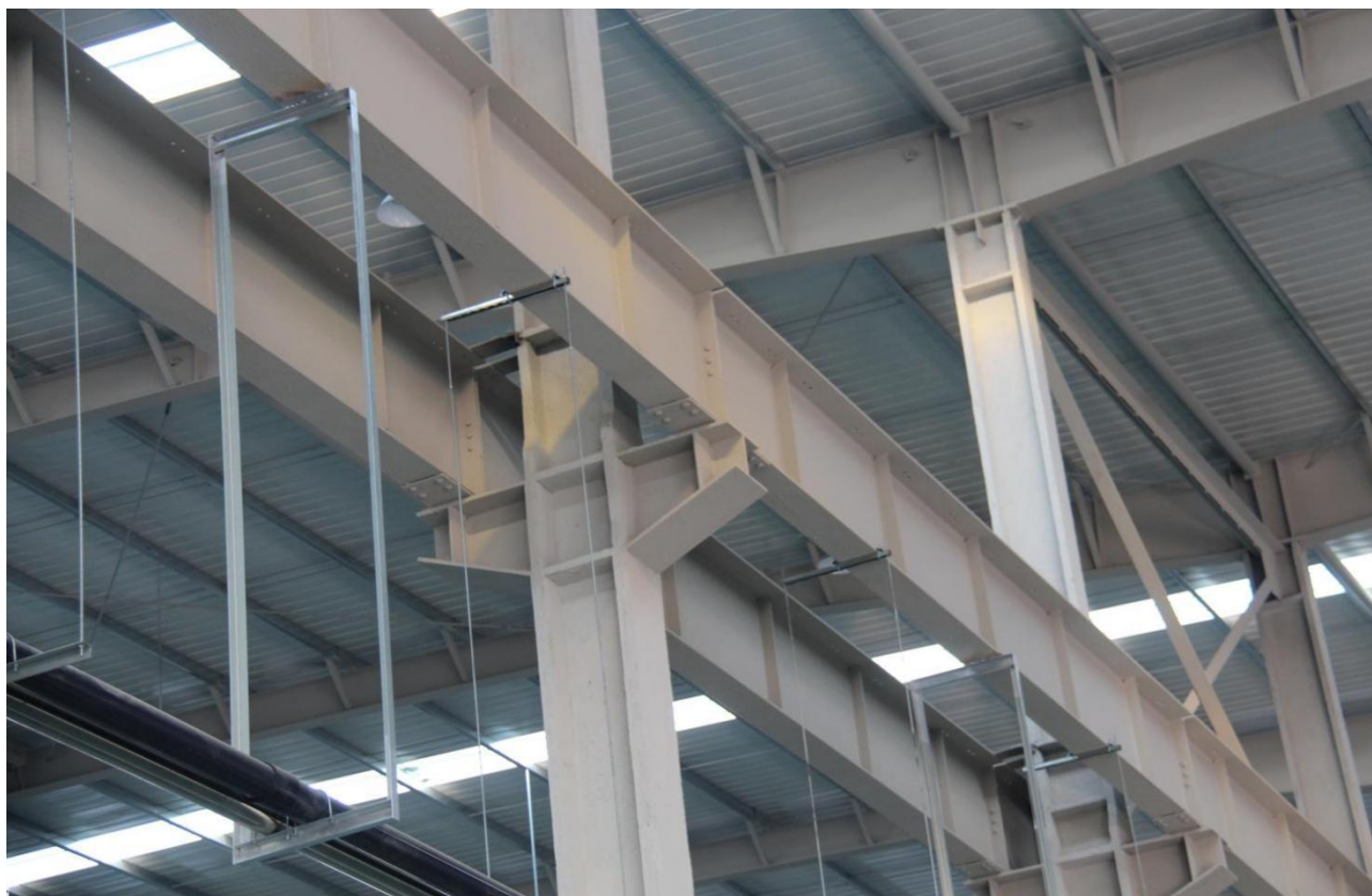
钢梁节点做工精良，安装平顺，防火涂装均匀完整
